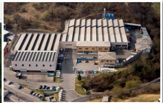
Stabilimento per valvole industriali 7.000 m 2 Plant for industrial valves 7.000 m 2
