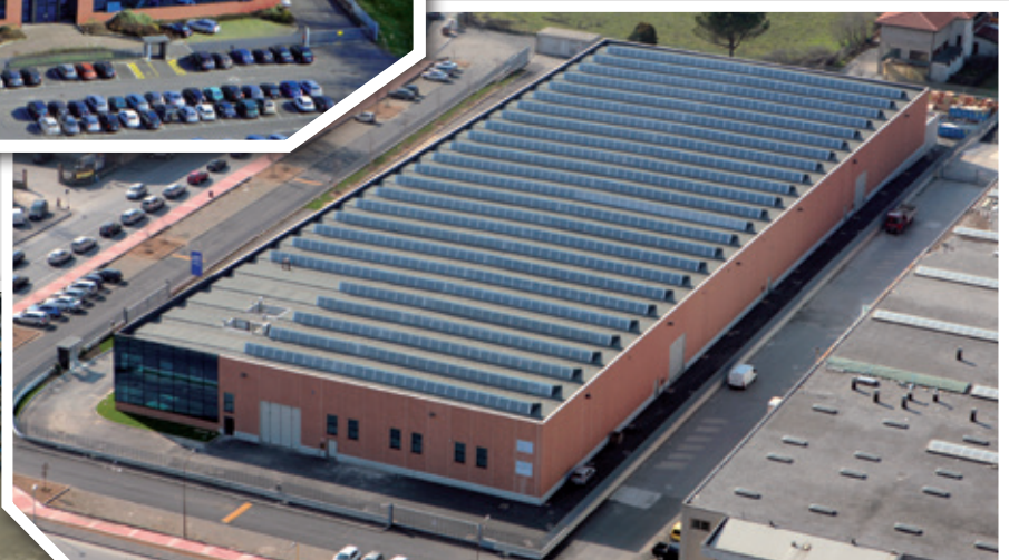
Centro logistico 7.000 m 2 - Logistic center 7.000 m 2
