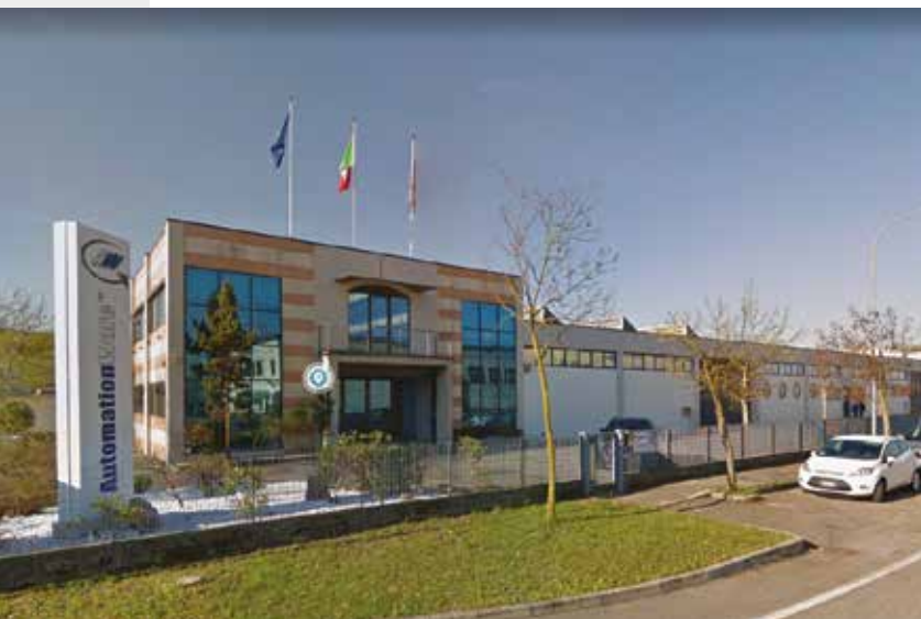
Una vista dell'ufficio tecnico di AutomationWare. L'azienda, con sede a Martellago, in provincia di Venezia, è riconosciuta per il profondo know-how maturato negli anni.
